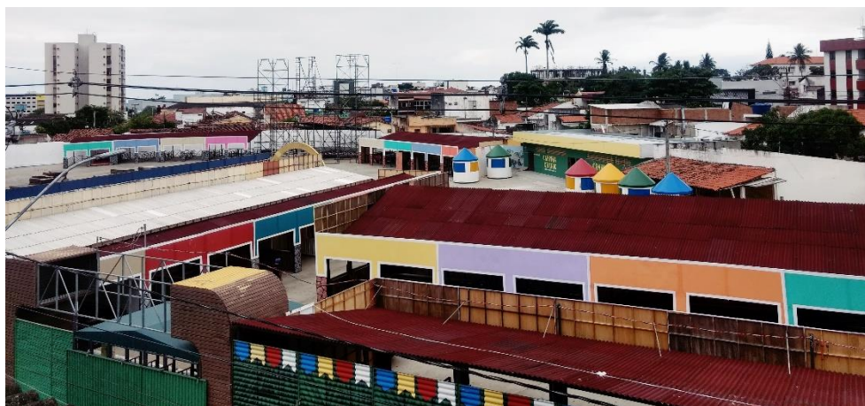
Figura 09: Montagem das estruturas do MSJM
