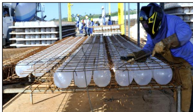
Figura 1 - Sistema construtivo de laje lisa tipo Bubbledeck . [ http://aligadaengenharia.blogspot.com.br ]
