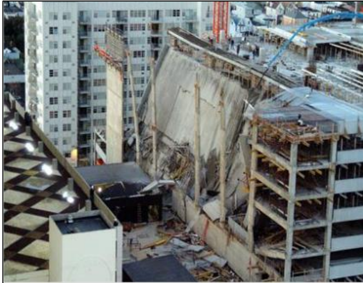
Figura 5 – Colapso do edifício de garagem Tropicana Casino . [ https://failures.wikispaces.com ]
