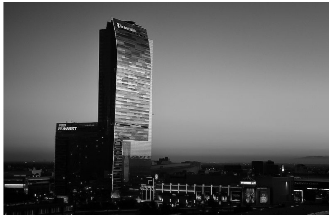
Figura 12 - Torre do hotel Ritz-Carlton em L.A.
