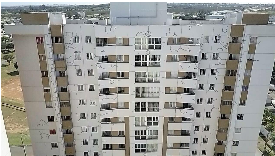
Figura 3.4 - Fachada 3 - Edifício A
