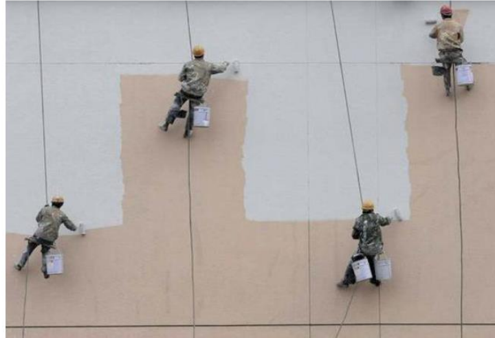
Figura 2.11- Panos aplicados simultaneamente para evitar emendas (ALMEIDA, 2012)
