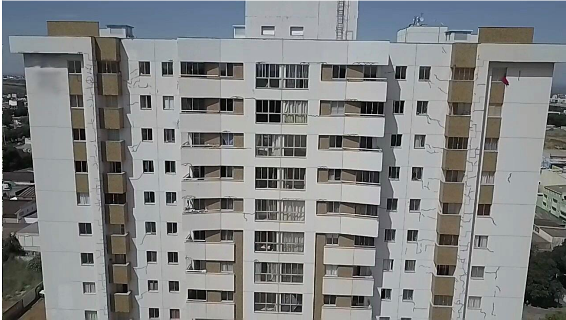
Figura 3.1- Fachada 1 – Edifício A
