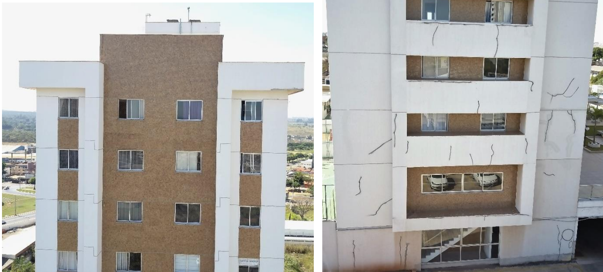
Figura 3.6 - Fachada 4 - Edifício A
