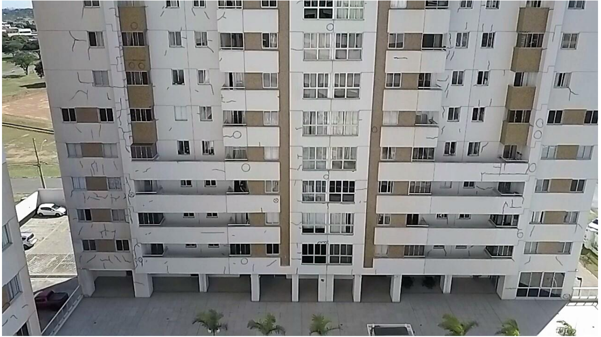
Figura 3.5 - Fachada 3 - Edifício A
