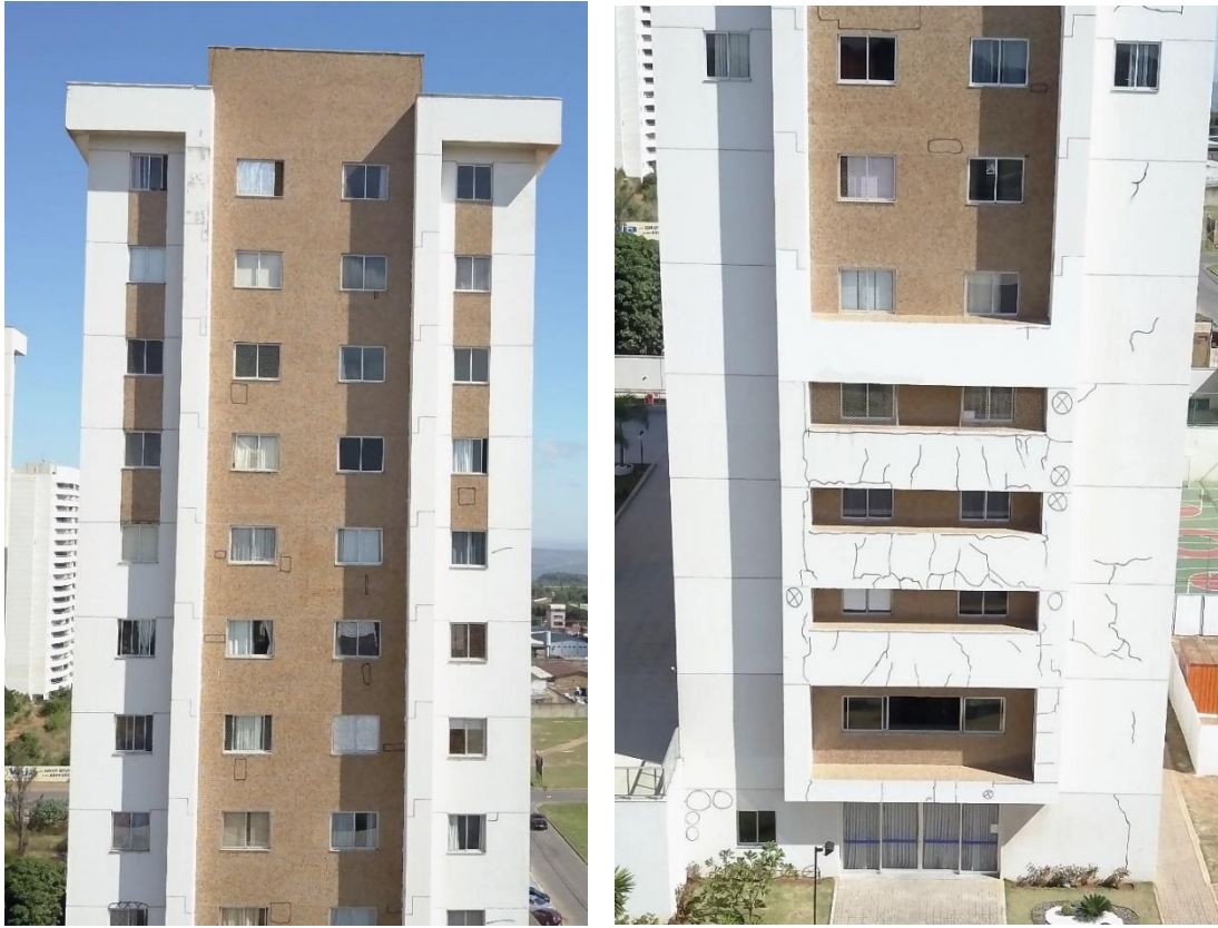
Figura 3.3 - Fachada 2 - Edifício A
