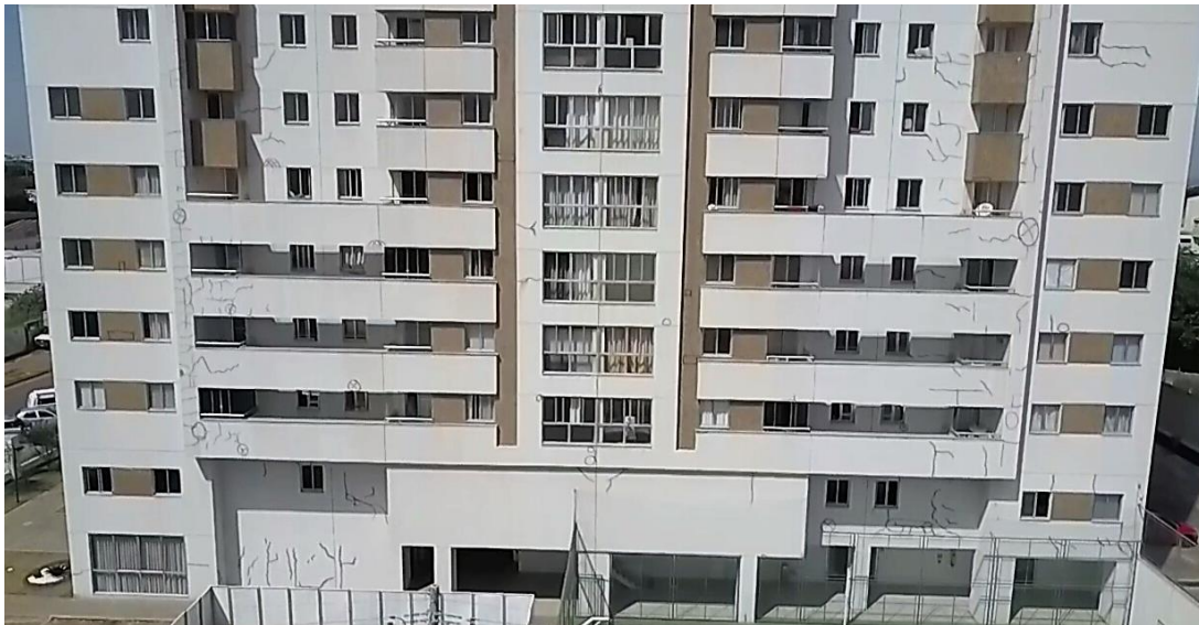
Figura 3.2 - Fachada 1 - Edifício A
