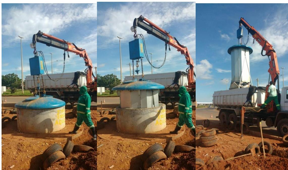
**Figura 3.6: Fases de coleta do contêiner semienterrado.**
