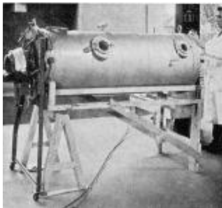
Figura 1-Iron Lung, que operava por pressão negativa (Fonte: ARREGUE, 2009)
