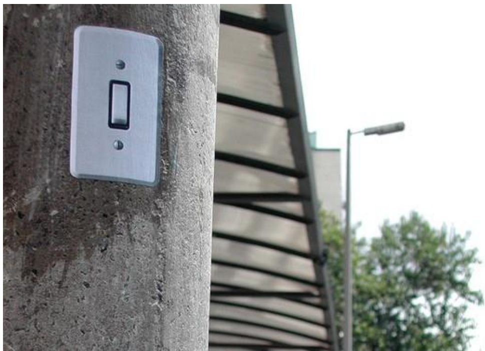
Figura 4: Interruptores para poste de luz (2005), Belo Horizonte/MG
