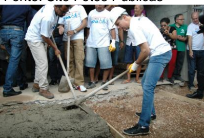
Imagem 36 – Dória concreta calçada Fonte: Site Fotos Públicas
