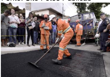
Imagem 35 – Dória asfalta pista Fonte: Site Fotos Públicas
