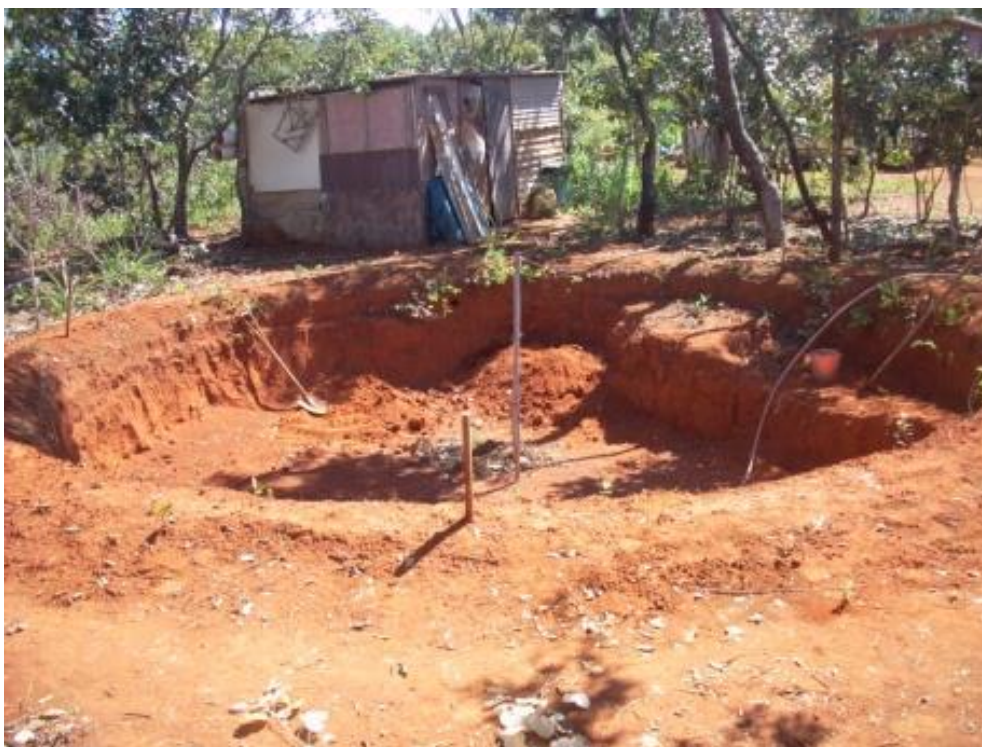
Figura 9 – Construção do Tanque de Peixe.
