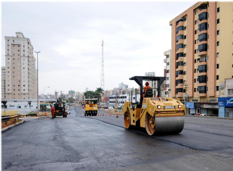
Figura 7: Obras de revitalização da cobertura asfáltica na Av. SAMDU norte – Taguatinga.
