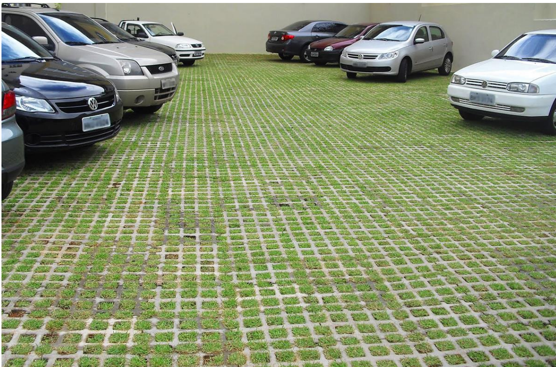
Figura 19. Exemplo de pavimentação permeável no Brasil. Fonte: Google Imagens
