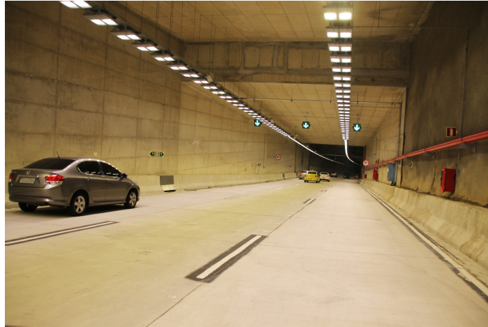
Figura 5.3: Emboque do túnel Marcello Alencar em seção retangular (PORTO MARAVILHA, 2017)
