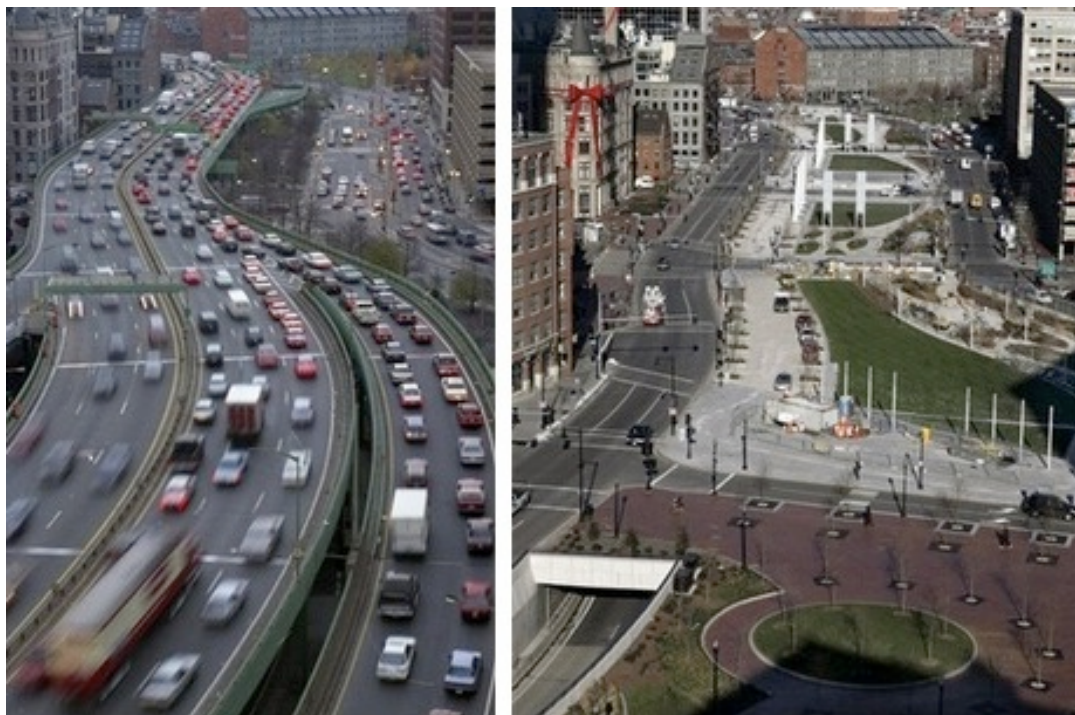
Figura 2.3: Antes e depois da imploração da Central Artery e construção do Big Dig (MENINO, 2013)
