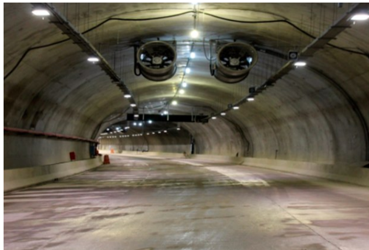
Figura 5.4: Seção arco-retângulo do túnel Marcello Alencar (O DIA, 2016)
