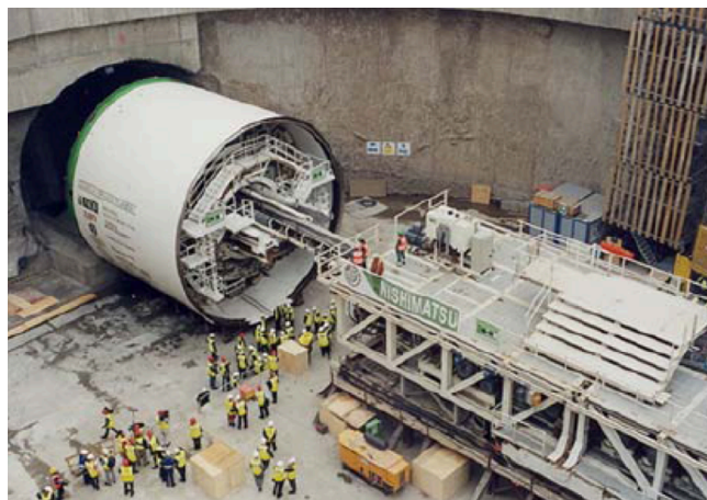
Figura 3.3: Tuneladora em operação no porto de Dublin (SAUER et MERGELSBERG, 2004)
