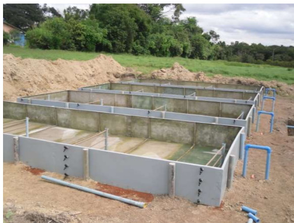
FIGURA 4. Vista interna dos leitos antes do preenchimento com brita com detalhe do sistema do controle do nível (cavelete) de efluente no interior dos leitos.
