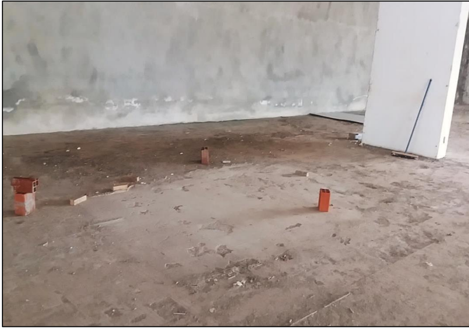
Figura 6.3 – Região do Piso Superior submetida à análise, após limpeza.
