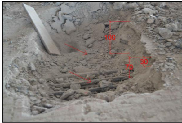
Figura 6.11 – Abertura executada com martelete.
