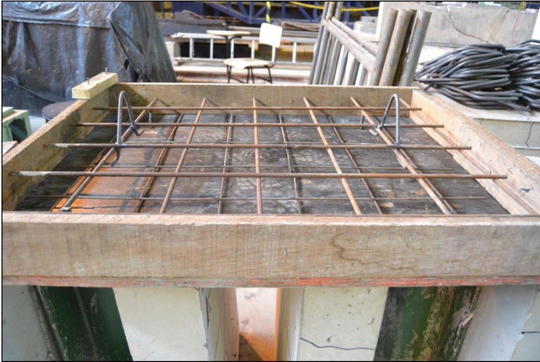
Figura 5.5 – Fôrma da placa moldada no laboratório.
