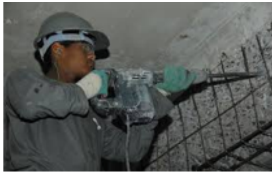
Figura 2.3- Exemplo de retirada do concreto com martelo mecânico (pt.slideshare.net/jeanpaulomendes, 2014)
