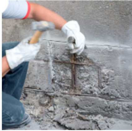
Figura 2.2- Exemplo de retirada do concreto de modo manual (construcaomercado.pini.com.br, 20/11/2015)
