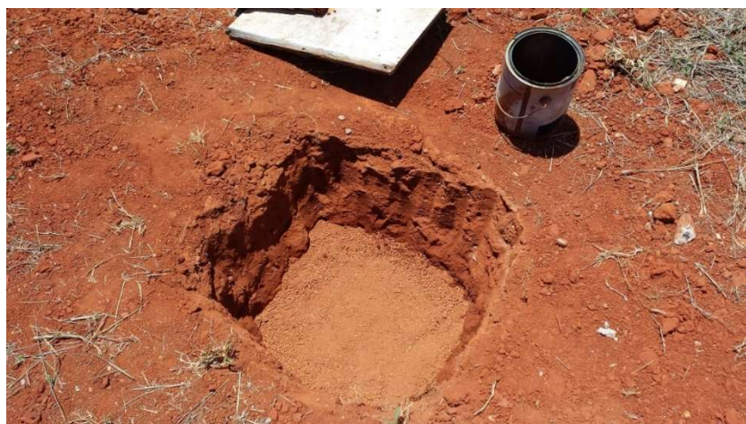
Fig. 3.7: Execução da camada reforçada in-situ
