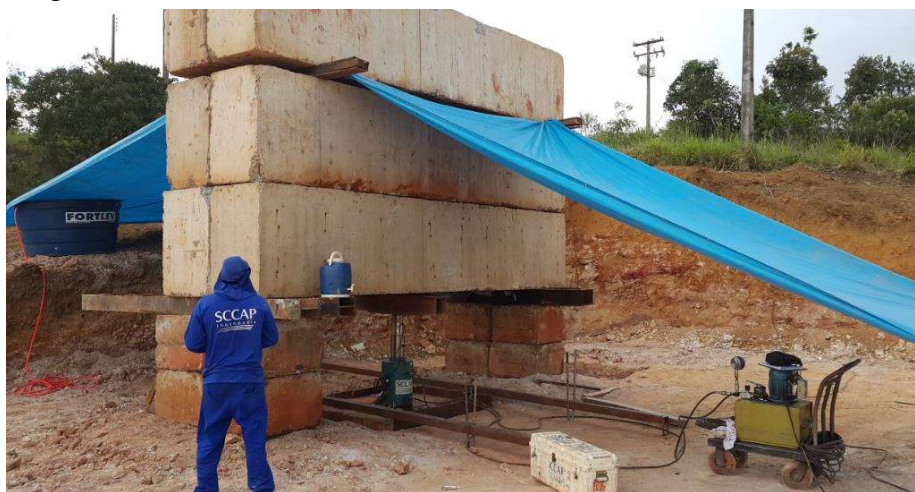
Fig. 2.8: Montagem de Prova de Carga – (Fonte: KALI ENGENHARIA)
