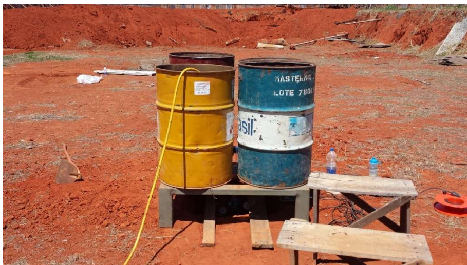
Fig. 3.3: Tonéis metálicos sendo preenchidos com água
