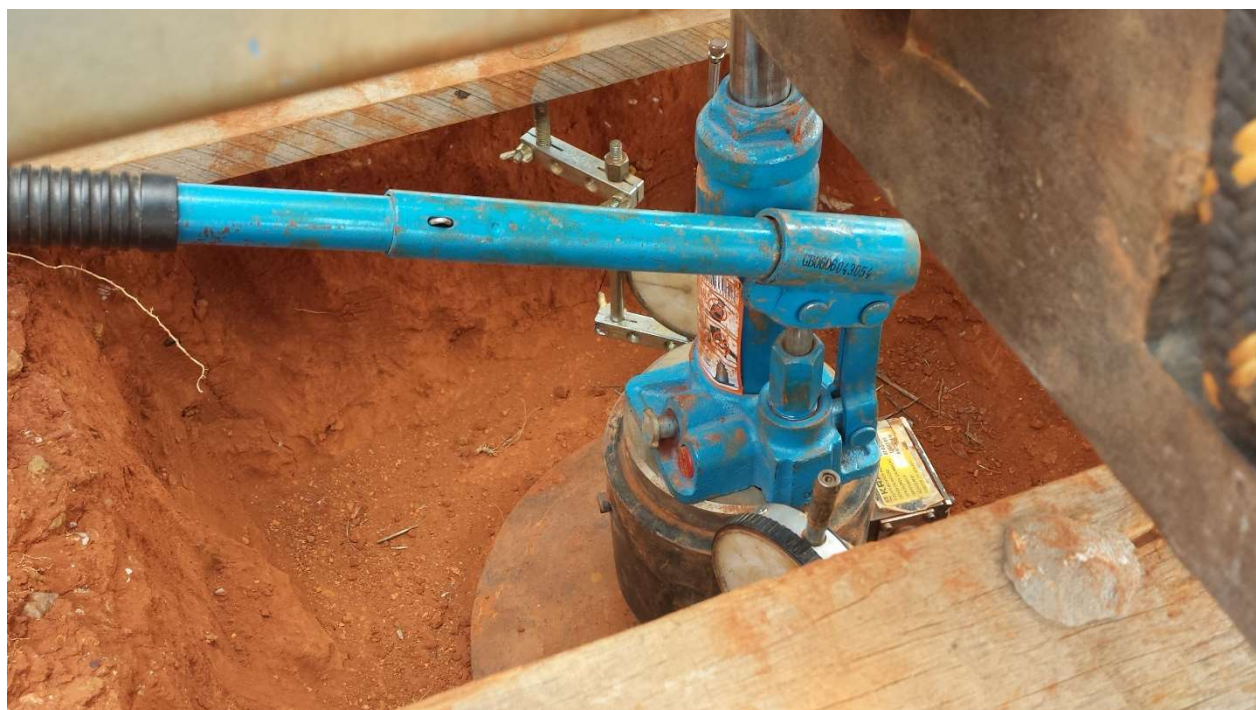
Fig. 3.9: Aplicação de carregamento na placa com uso do macaco hidráulico
