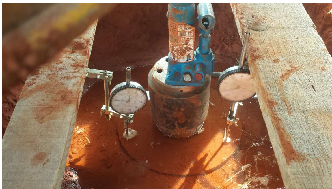
Fig. 3.5: Inundação da prova de carga durante execução
