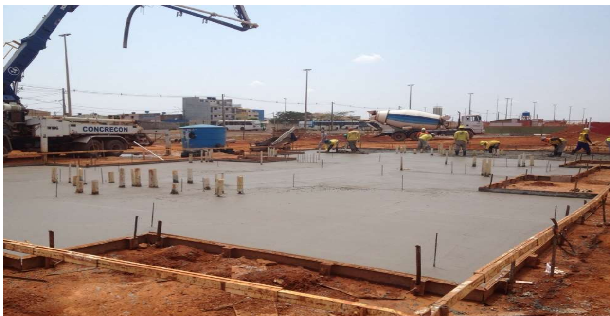
Fig. 2.2: Execução de Fundação Radier em Brasília. (Fonte: KALI ENGENHARIA)
