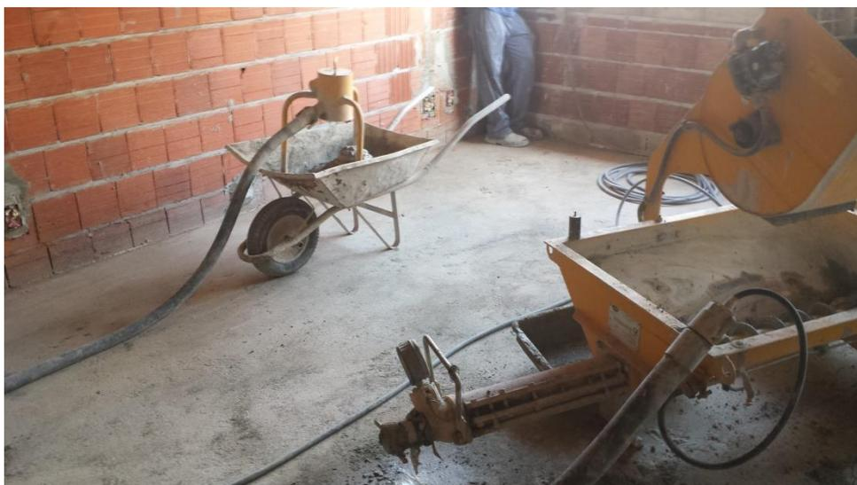
Figura 34- Limpeza dos mangotes e desmonte da bomba de projeção feita ao final do expediente
