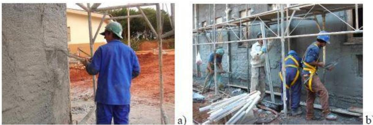
Figura 10- Projeção da argamassa (a) e execução do sarrafeamento e desempenho(b) na fachada da empresa V ( PARAVISI, 2008);
