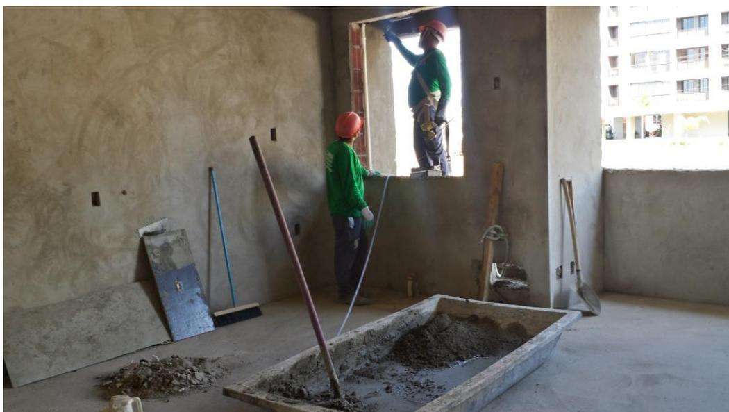
Figura 40 – Equipe 1z, constituída por 1 pedreiro e 1 ajudante, realizando o processo de requadrção no sistema convencional de revestimento.
