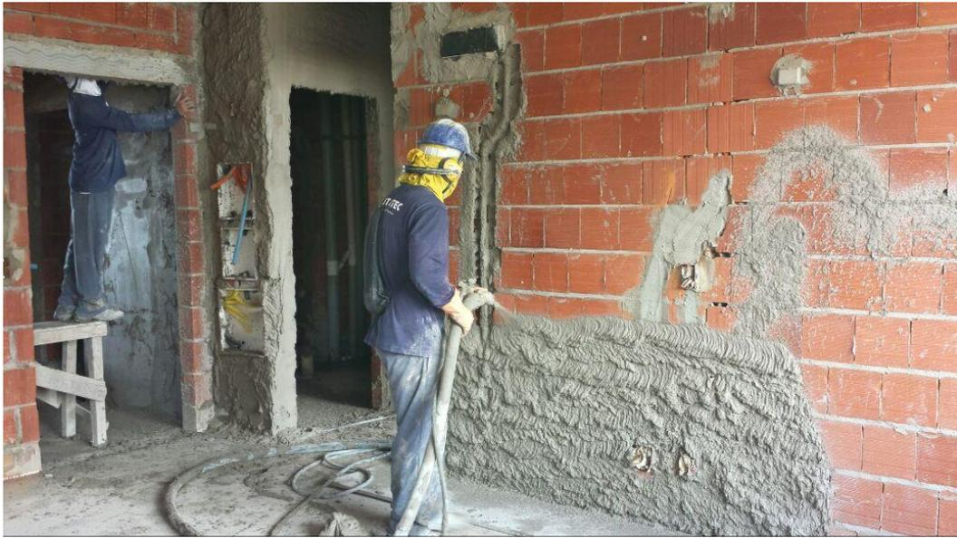
Figura 30 – Pedreiro executando a projeção da argamassa na alvenaria com movimentos horizontais no sentido de baixo para cima.
