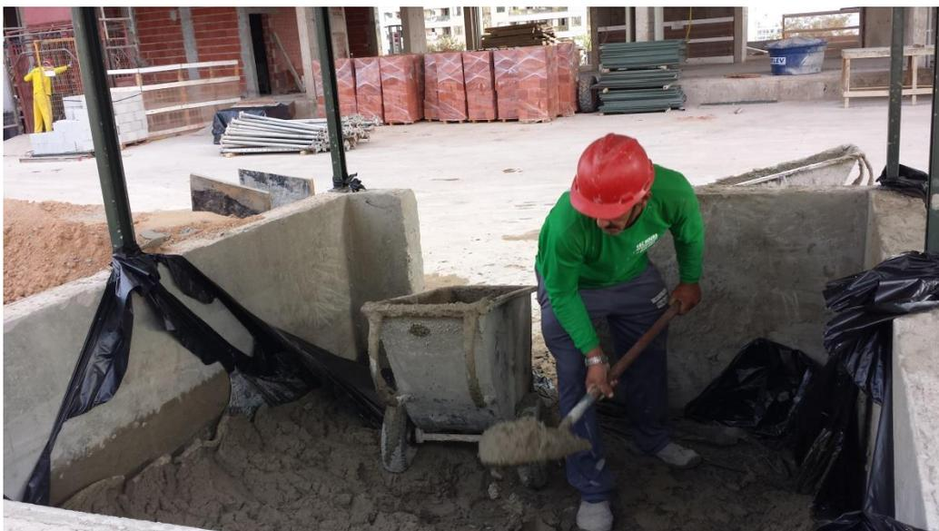
Figura 18 – Local de Armazenamento da Argamassa usinada fornecida pela Concrecon que foi utilizada no sistema de revestimento em argamassa convencional
