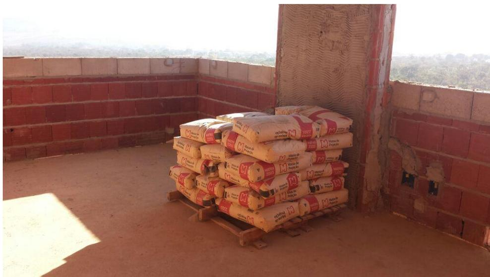
Figura 28 - Armazenamento da argamassa ensacada em regiões próximas as bombas de projeção.
