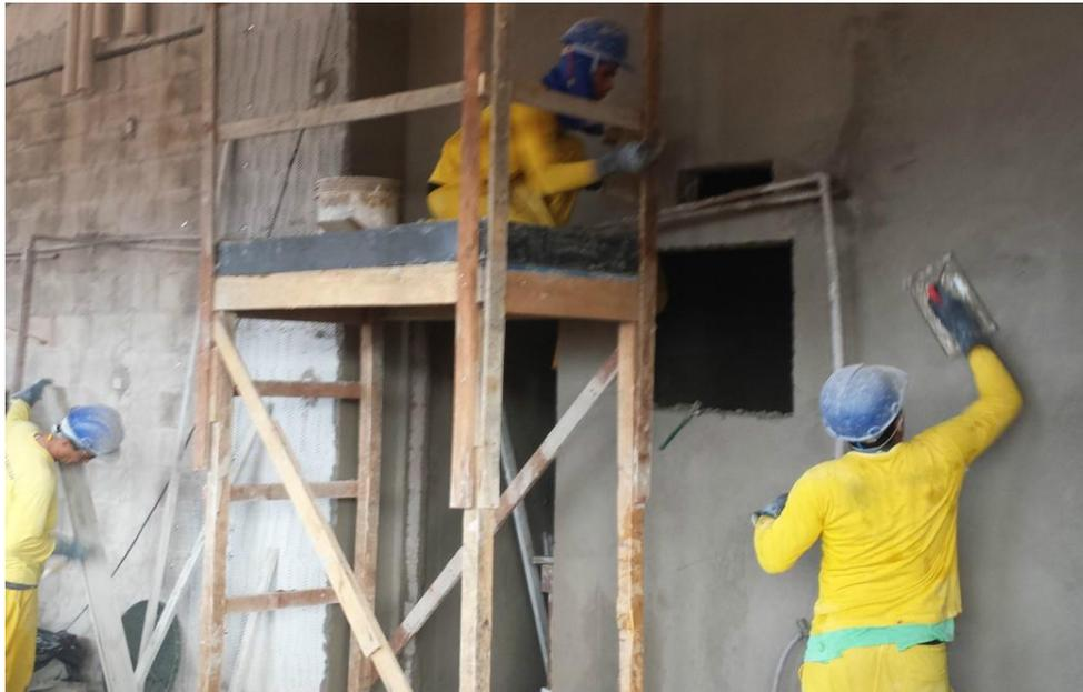
Figura 32- Equipe de pedreiros realizando o sarrafeamento e o desempenho da alvenaria revestida em argamassa de projeção
