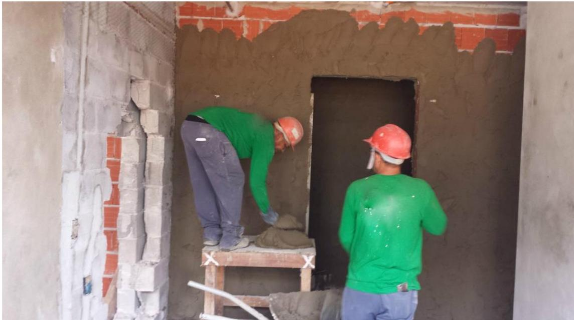
Figura 19 – Equipe 1z, constituída de 1 pedreiro e 1 ajudante, responsável em realizar o reboco do apartamento 108 pelo método convencional.
