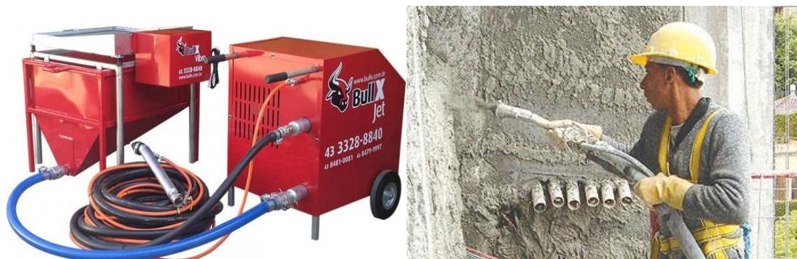
Figura 2- a) Bomba de Projeção de Argamassa, b) Aplicação da argamassa projetada usando bombas (TECHNE, 2010)
