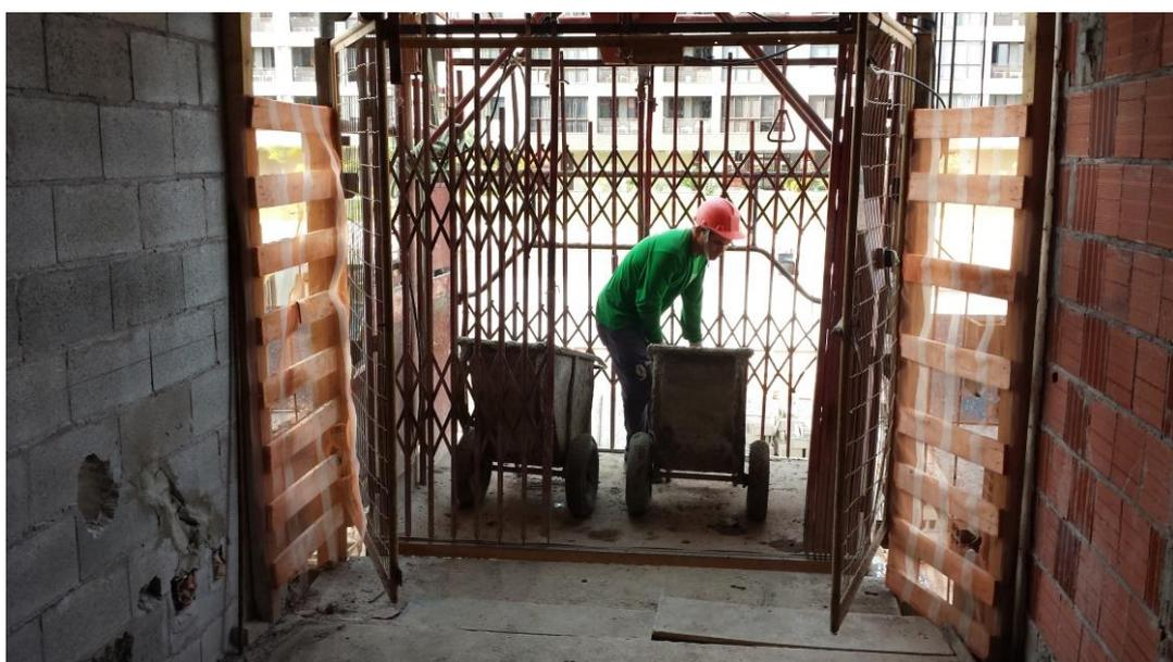
Figura 20- Transporte vertical da argamassa usinada em jericas por meio da prancha mecânica
