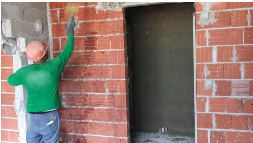
Figura 21 – Processo de umedecimento da alvenaria realizado previamente a etapa do lançamento da argamassa no substrato
