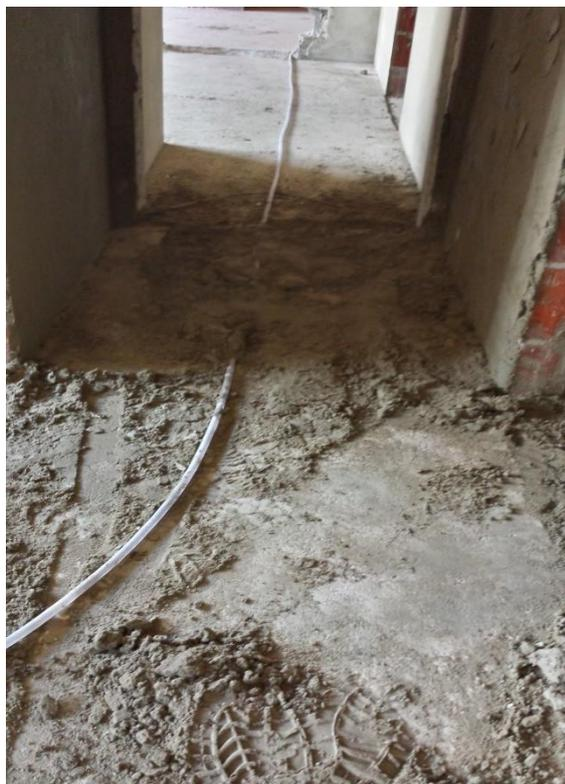
Figura 42 – Argamassa usinada não reaproveitada proveniente de quedas durante o transporte e vencimento do seu tempo de vida útil.
