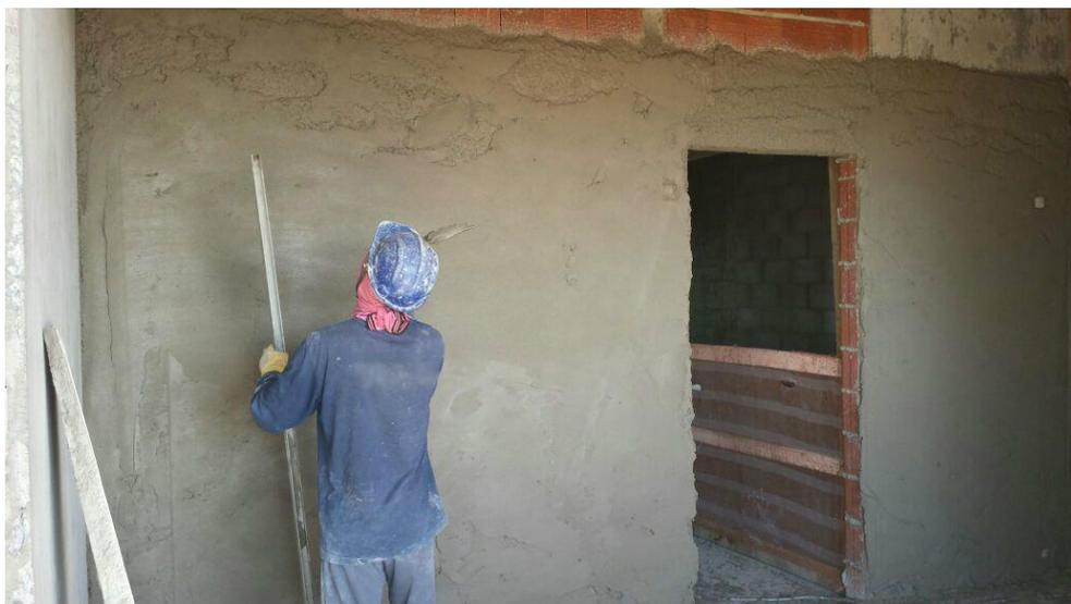
Figura 31 – Primeira regularização do revestimento feito com régua H e colher de pedreiro, procedimento feito logo após a projeção da argamassa na alvenaria.
