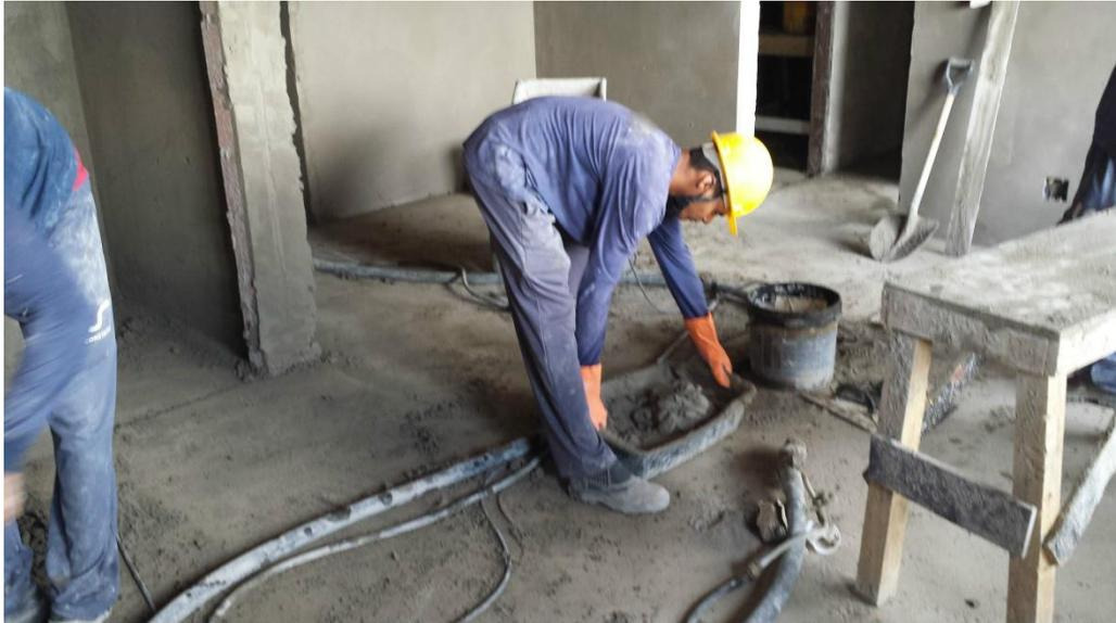
Figura 33 – Após a regularização do reboco na alvenaria, a argamassa que caía no chão era reaproveitada em outras projeções, respeitando o tempo de vida de 2 horas.
