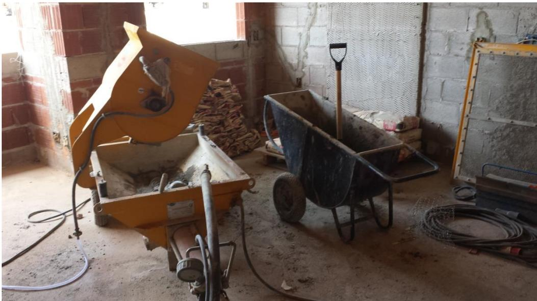
Figura 43 – Reutilização da argamassa coletada do chão e despojada na bomba de projeção
