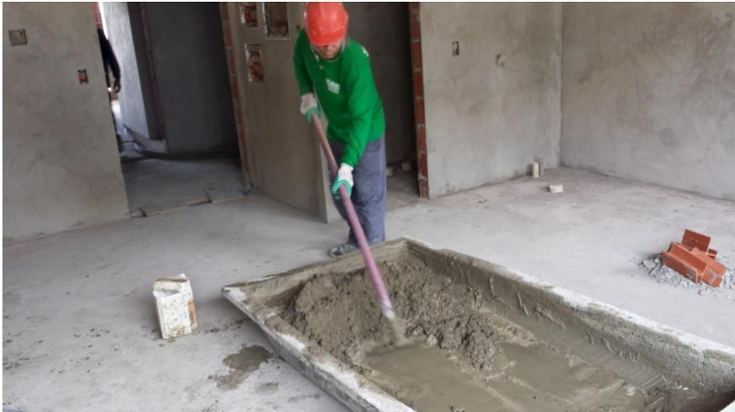
Figura 24 – Reaproveitamento da argamassa usinada residual das etapas de lançamento e sarrafeamento, processo realizado pelo ajudante na argamassadeira.
