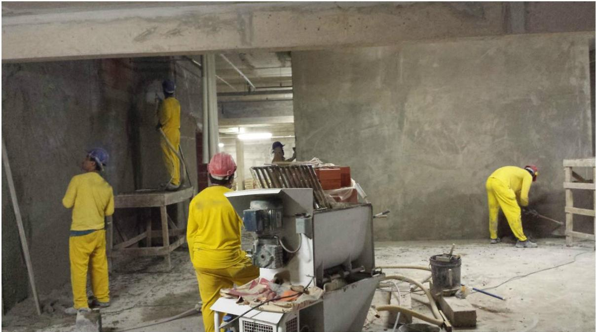
Figura 41 – Equipe 1x, constituída de 4 pedreiros e 2 ajudantes, executando o reboco pelo método projetado no subsolo.
