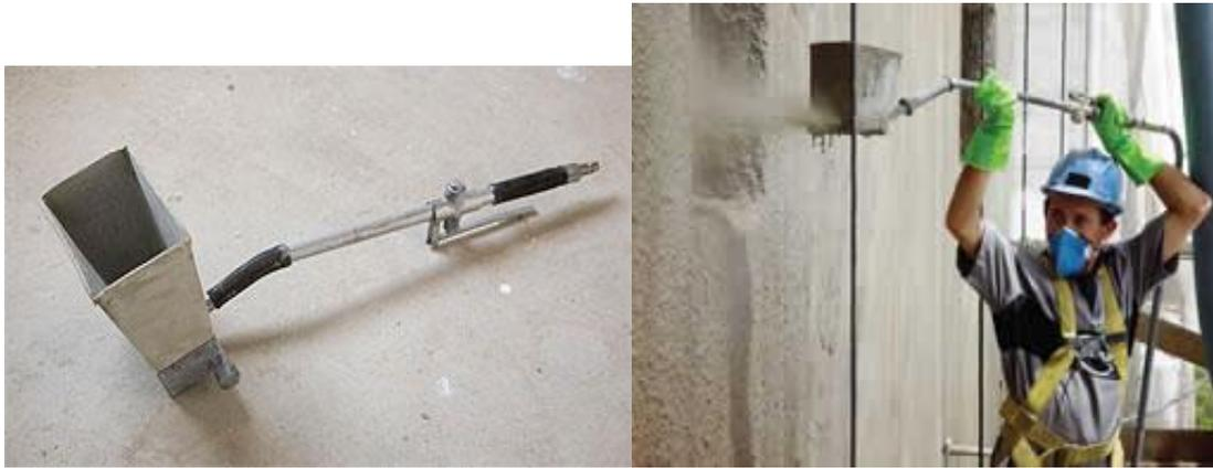
Figura 3- a) Projetor com recipiente acoplado, conhecido como "canequinha". b) Projeção realizada com a canequinha ( TECHNE, 2010)
