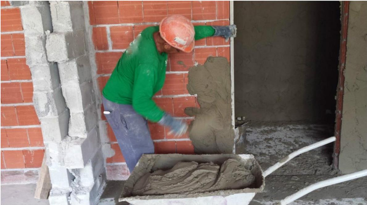
Figura 22 - Lançamento da argamassa usinada na alvenaria com colher de pedreiro e sendo feito de baixo para a cima.
