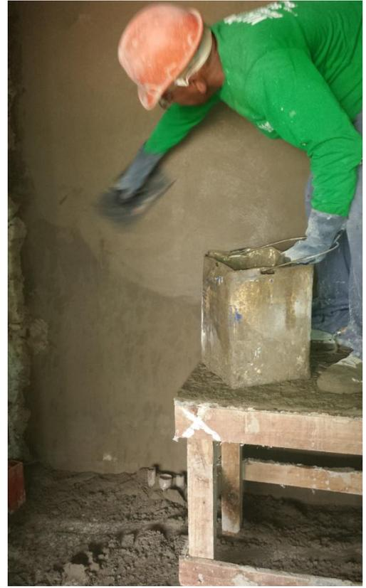
Figura 23 - a) Etapa de sarrafeamento após o tempo de pega da argamassa feito pelo pedreiro e régua .
