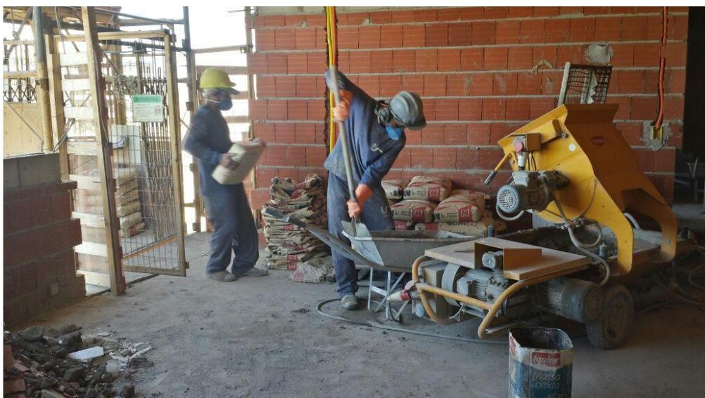
Figura 27- Movimentação vertical da argamassa de projeção através das pranchas mecânicas e armazenamento de sacos bem próximo à bomba de projeção.
