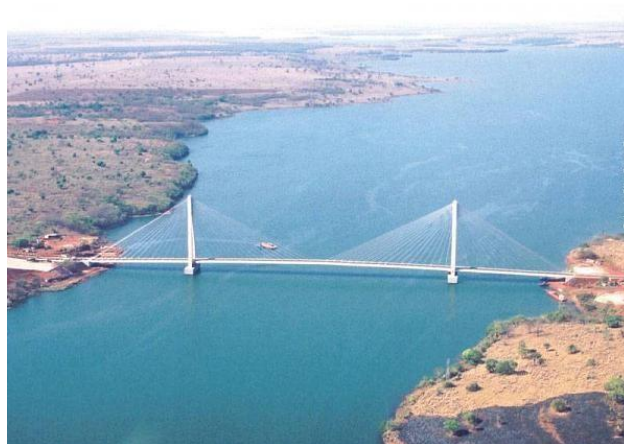
Figura 20 - Ponte Porto Alencastro. Fonte: www.wikimapia.org
