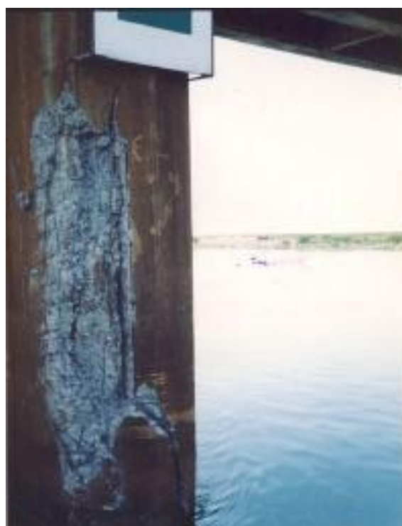
Figura 4 - Acidente no pilar da ponte da BR-153. Fonte: DH-SP (2013)
