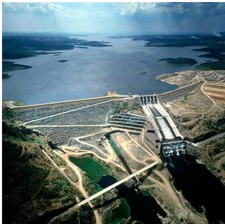
Figura 5.1: Barragem Pedra do Cavalo
