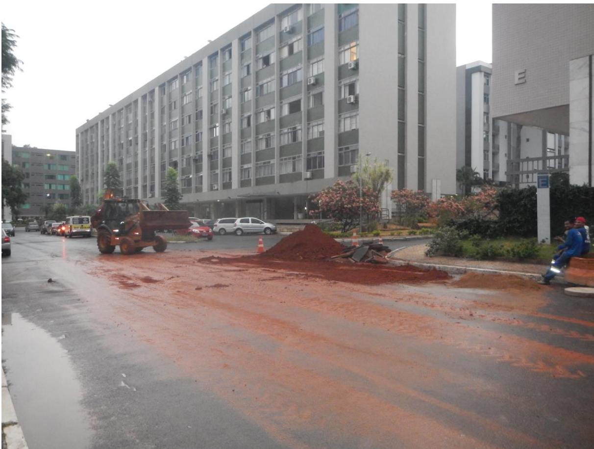
Figura 5.24– Obra na semana da coleta de dados na Superquadra Norte 202
