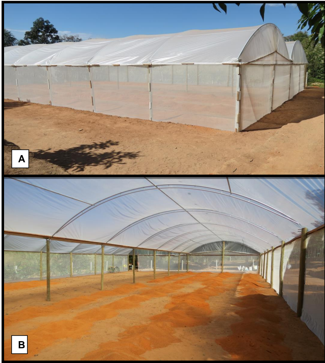
Figura 5. Vista da estufa construída. A) Vista lateral; B) Vista interna. Fotos: Igor Bacon Carvalho.
