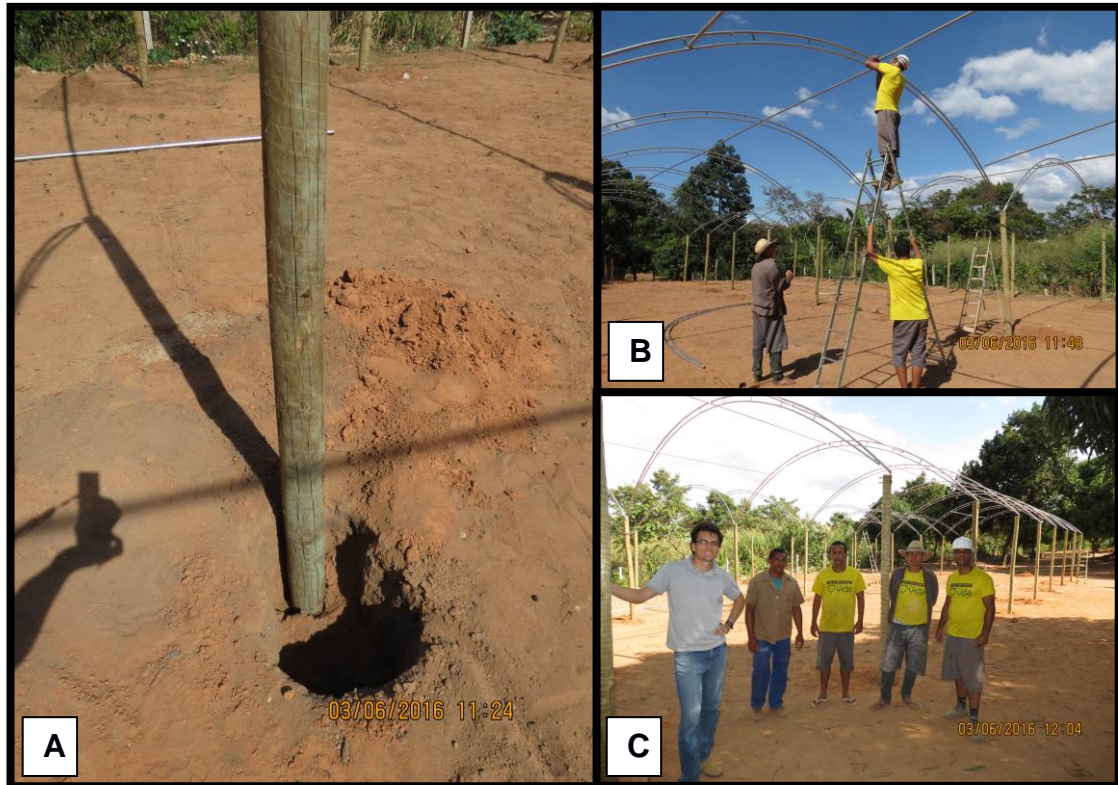
Figura 4. Construção da estufa agrícola. A) Fixação do mourão de eucalipto; B) Instalação dos arcos de metal; C) Equipe responsável pela construção.
