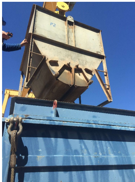
Figura 60 – Caçamba dosadora de concreto (Fonte: autora)
