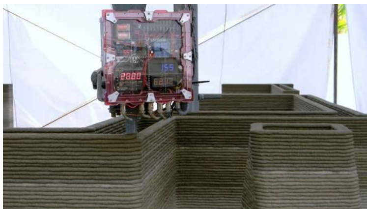
Figura 7 – Impressão de um hotel por TotalKustom (Fonte: Rudenko, 2016)
