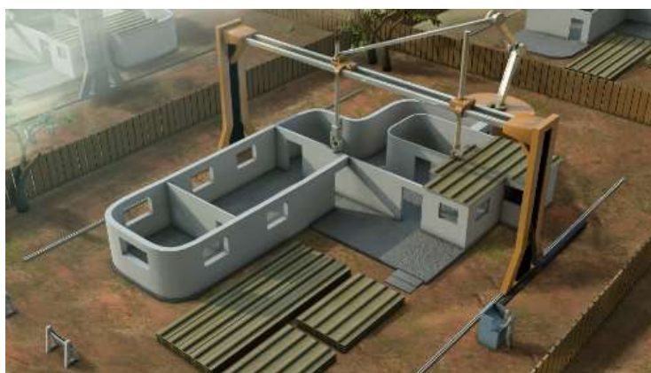
Figura 6 – Impressão de um edifício utilizando-se a técnica CC (Fonte: Contour Crafting, 2016 )
