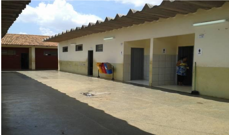
Figura 7: Foto dos banheiros dos alunos e das salas de aula, 07/10/2015
