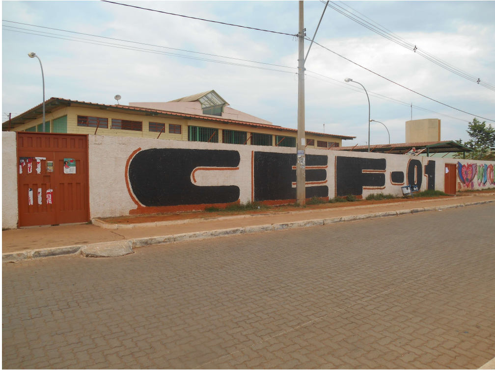
Figura 01 – Fachada do CEF 01
