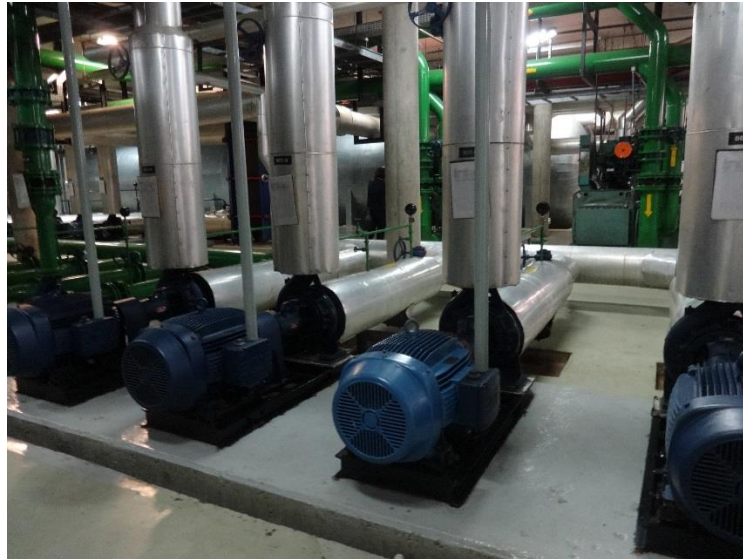
Figura 6. 8 - Bombas de etileno glicol
