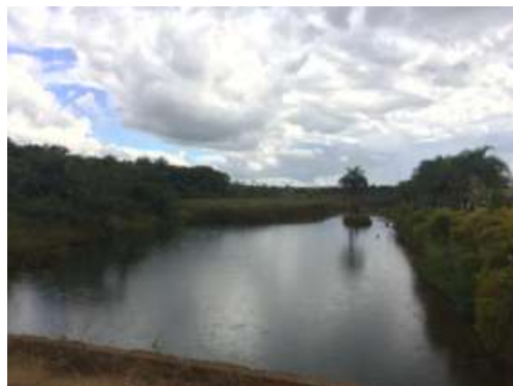
Figura 28 – Bacia de contenção do Setor Nordeste.
