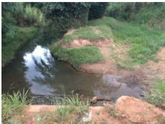
Figura 27 – Bacia de contenção não finalizada no bairro Parque da Colina.
