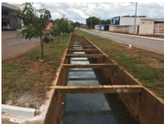
Figura 13 – Canal da Avenida Ivone Saad. Fonte: a autora.
