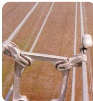
Figura 4.4 – Pavica instalado próximo a um espaçador (COSMAI, 2009).
