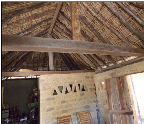
Foto 13 – Interior da casa pronta
