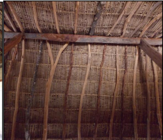
Foto 14 – Interior da casa pronta
