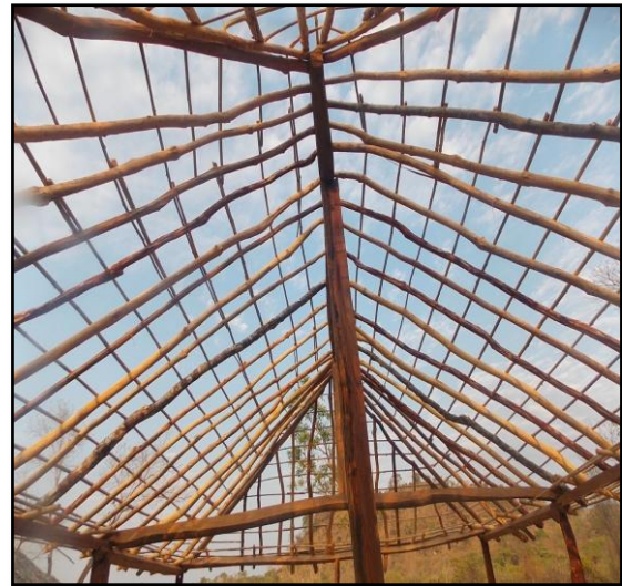
Foto 8 - Construção da casa Kalunga
