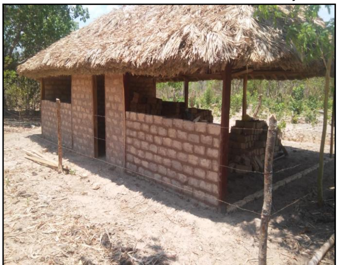
Foto 12 – Casa em construção
