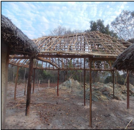
Foto 7 - Construção da casa Kalunga
