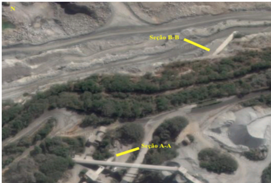
Figura 33 – Foto aérea da localização da obra (modificado - Google Earth, 2015)
