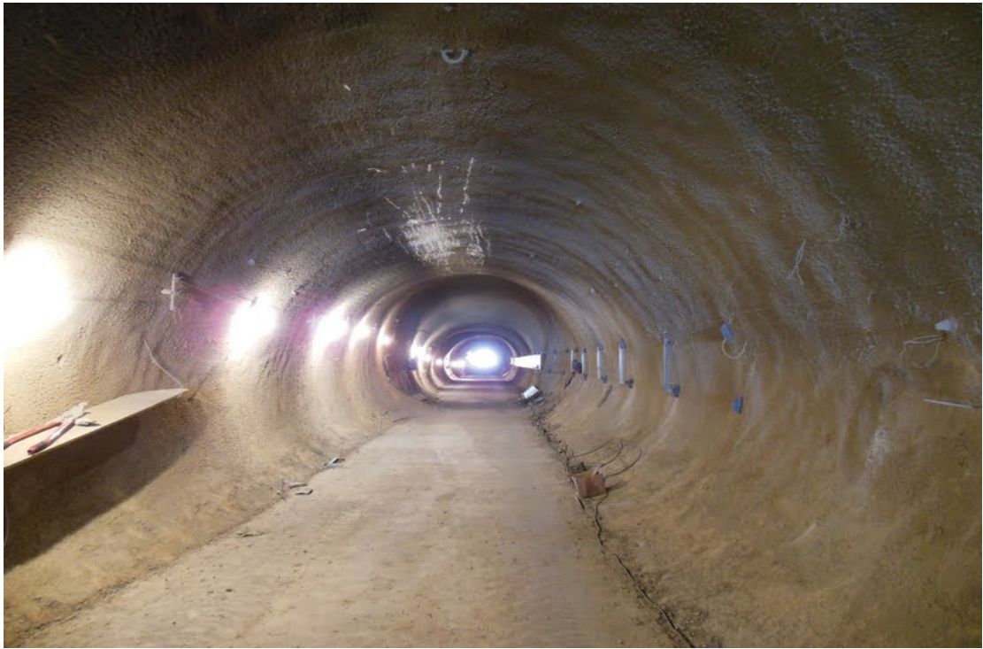
Figura 39 – Interior do túnel pronto em processo de acabamento para a colocação da transportadora. Detalhe dos agulhamentos com tirantes nas laterais. (Barbosa, 2012)
