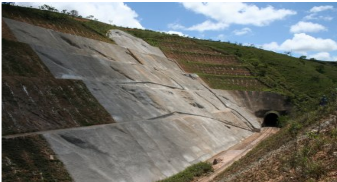
Figura 25 – Concreto projetado para estabilização de talude de ferrovia (Solotrat, 2015)
