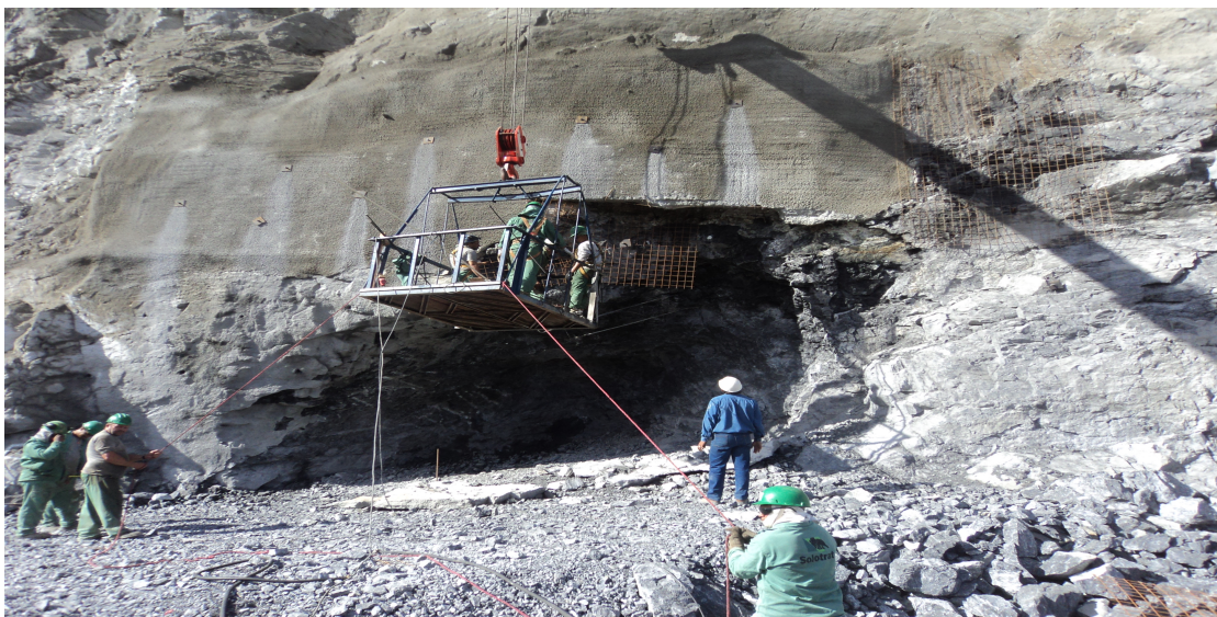
Figura 37 – Execução de enfilagens de barra injetadas com resina no emboque B-B (Barbosa, 2012)
