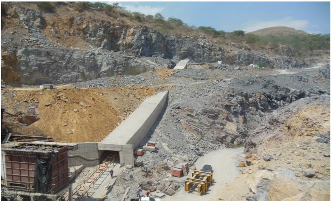
Figura 40 – Detalhe da transportadora instalada e da junção entre o túnel, em formato oval e a galeria, em formato retangular (Barbosa, 2012)
