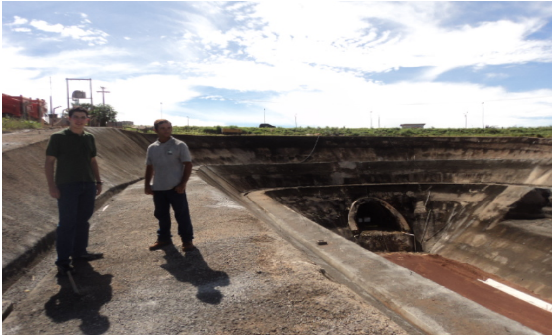
Figura 32 – Autor desta monografia, à esquerda, junto ao mestre-de-obras da Solotrat, Marcelo Silva, a responsável pelo rebaixamento por poços injetores da obra. Vê-se o detalhe do emboque Sul do túnel. (Barbosa, 2012)
