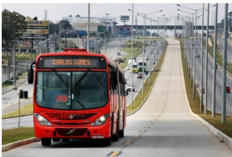
Figura 9. Corredor BRT em Curitiba (BRTBrasil.org)
