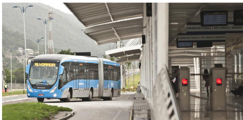
Figura 1. Estrutura BRT no Rio de Janeiro (BRTData.org).
