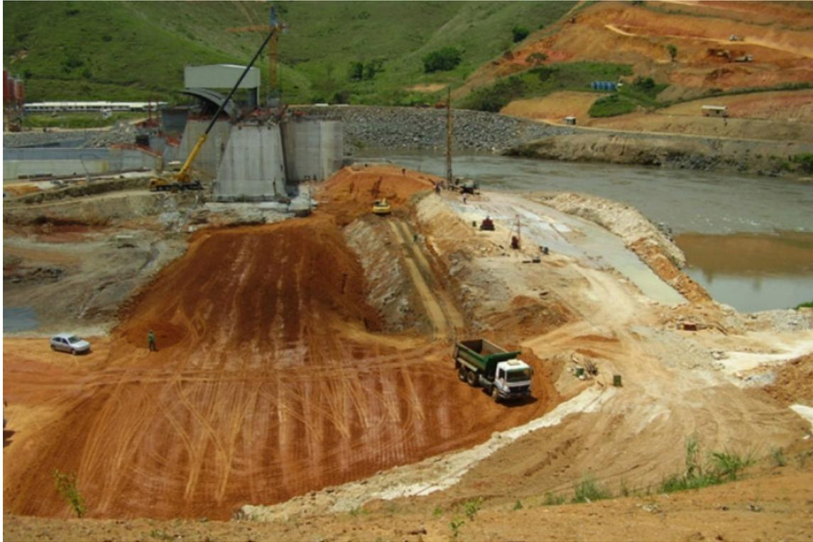
Figura 2.18: Final da execução da cortina de jet grouting – PCH Queluz (Novatecna, 2010).
