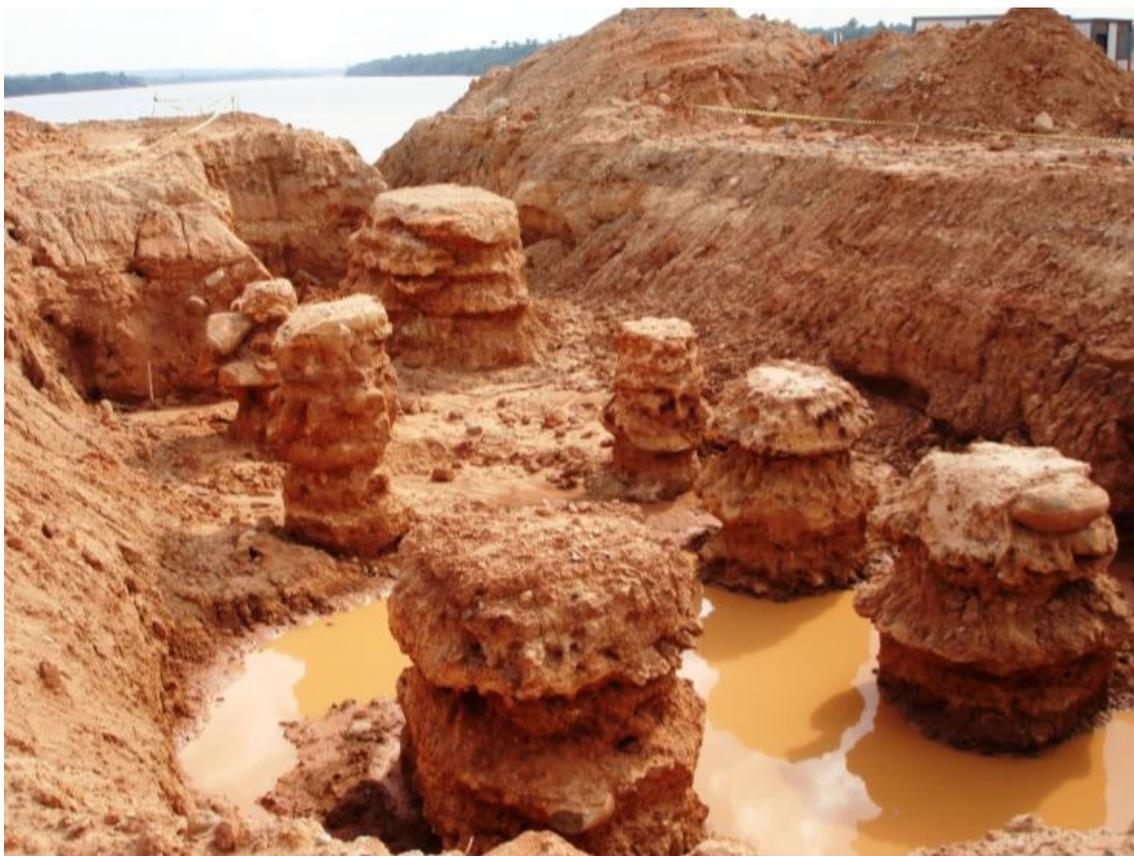
Figura 2.15: Campo de teste de colunas – UHE Estreito (Novatecna, 2008).
