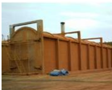
Figura 2.2. Forno de alvenaria de grande porte para produção de carvão vegetal (Fonte: www.inee.org.br ).
