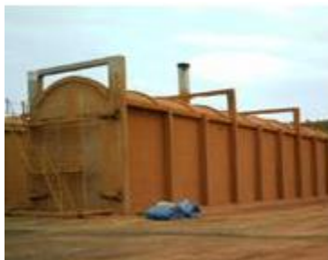
Figura 2.3. Forno de alvenaria de grande porte para produção de carvão vegetal (Fonte: www.inee.org.br ).
