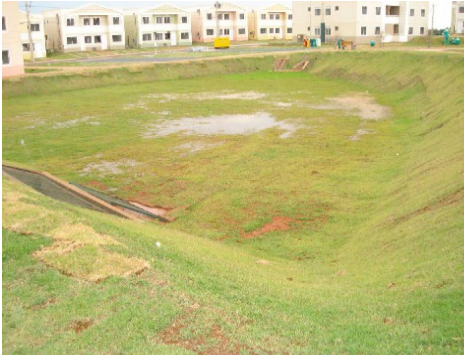
Figura 14 : Lagoa construída para reduzir a força da água proveniente da rede de drenagem de águas pluviais. Fotografia feita pela autora, abril 2013 .
