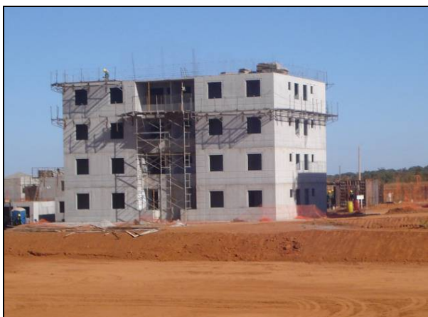
Figura 6 : Método construtivo ferro e cimento. Fotografia feita pela autora, abril, 2014.
