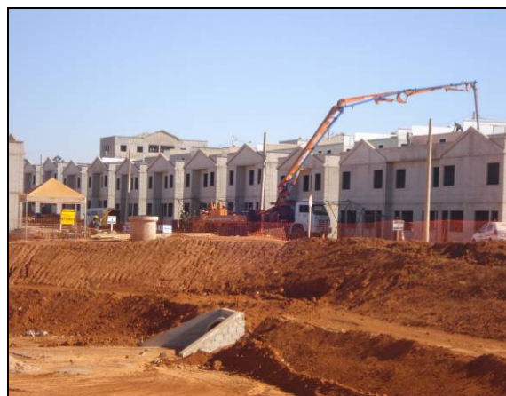
Figura 7 : Preenchimento de laje das edificações com concreto. Fotografia feita pela autora, abril, 2014.
