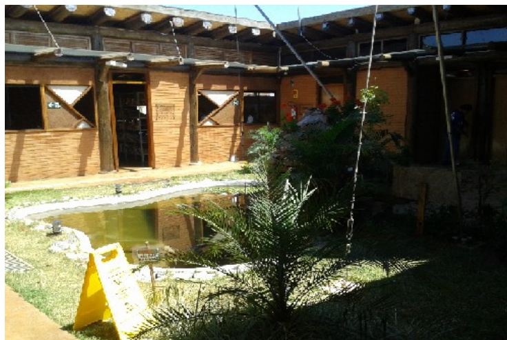
Figura 9: Área interna do prédio do CPS. Fotografia feita pela autora, outubro 2014.
