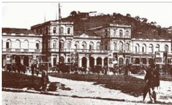
Figura 1 - Estação Central da Estrada de Ferro D. Pedro II. Acervo Memória da Eletricidade
