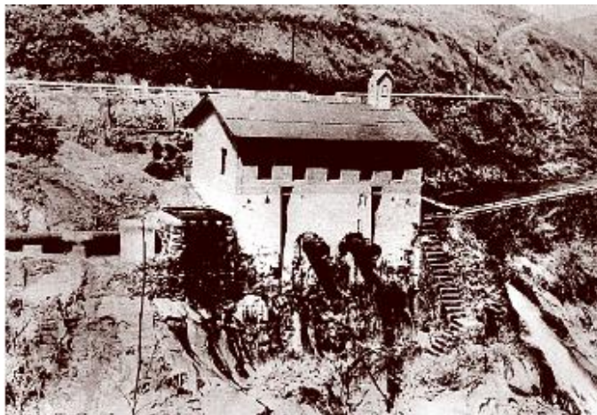
Figura 2 - Casa de força da Usina Hidrelétrica Marmelos-Zero, localizada no rio Paraibuna, Juiz de Fora-MG. Acervo Cemig.
