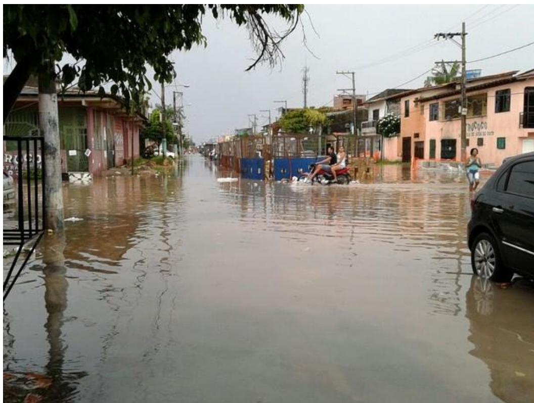
Foto 7: Alagamento na Rua Timbiras, Jurunas
