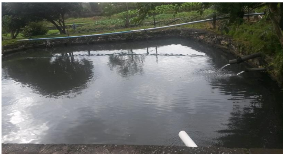
Figura 18 – Poço construído para irrigação artificial em uma das chácaras.
