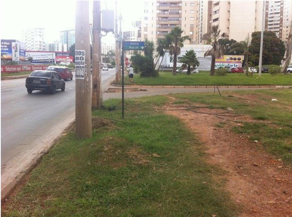
Figura 34: Falta do revestimento da calçada. Fonte do autor, 2015.
