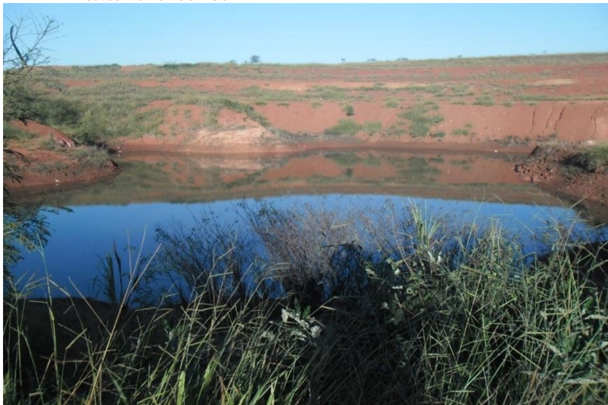
Figura 7 – Vista de barreiro desativado com formação de lago. Suspeita de afloramento do lençol freático. Bairro Bela Vista.
