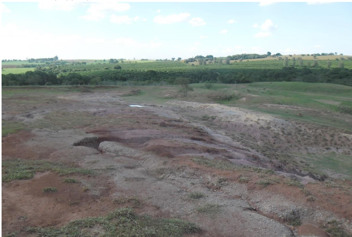
Figura 9 – Barreiro abandonado. Processos erosivos por falta de vegetação rasteira. Bairro Invernadinha.
