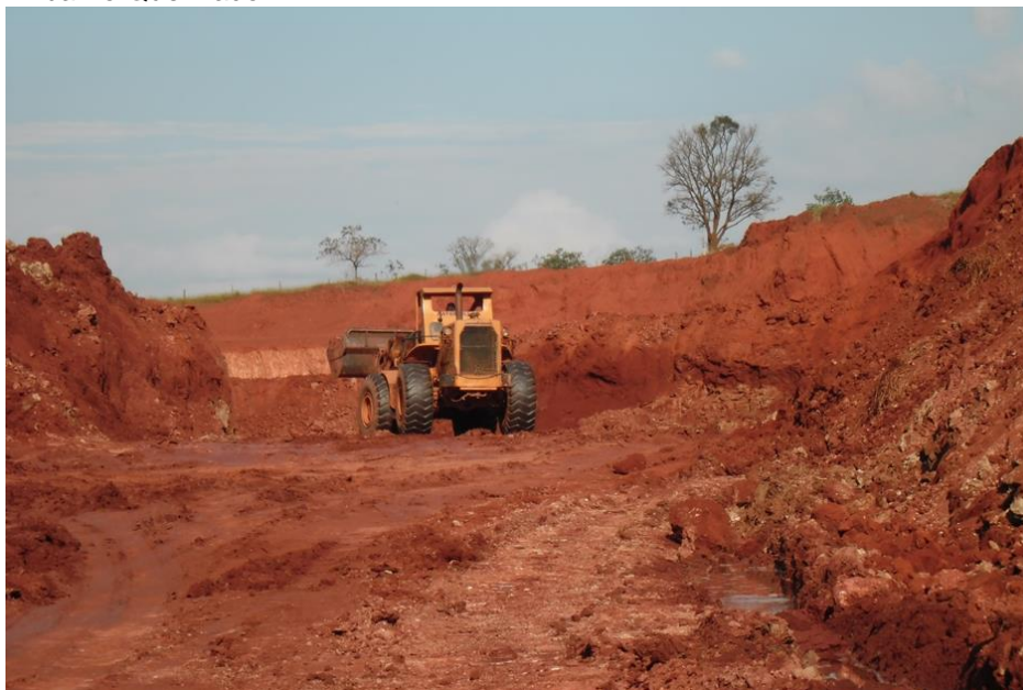
Figura 19 – Extração de argila, matéria prima para as indústrias de cerâmica vermelha. Bairro bairro Queimador.
