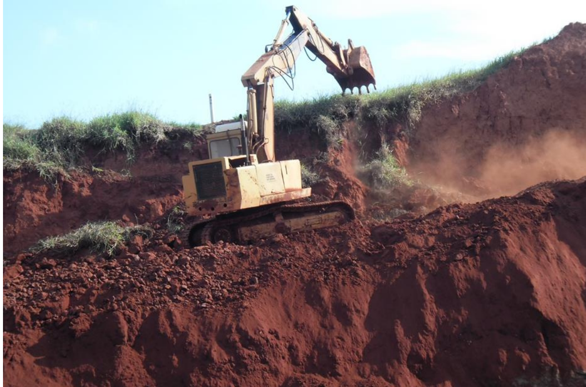
Figura 18 – Preparação do terreno para a extração de solo. Barreiro bairro Queimador.
