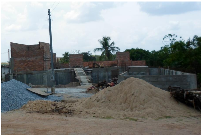
Figura 17 – Construção do Centro Comunitário.
