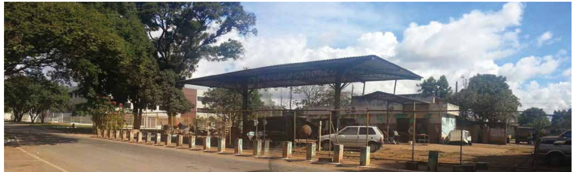
Figura 4 - Imagens atuais do terreno. Mostra a antiga cobertura do posto de lavagem e lubrificação que se tornou um depósito. Fonte: Arquivo pessoal da Emanuelle
